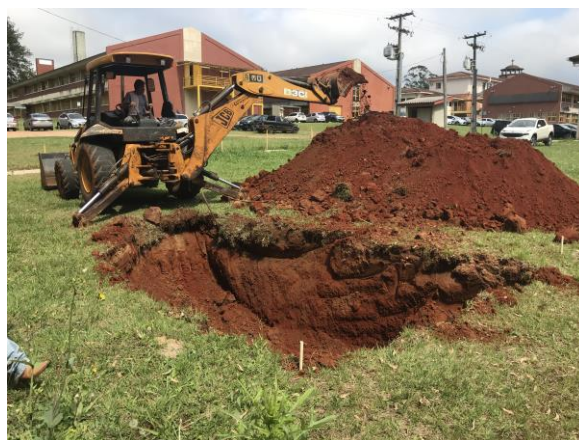
Figura 2. Escavação do solo (Autoria própria, 2019)
